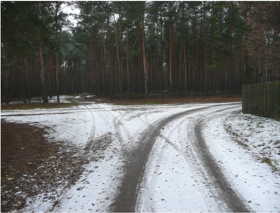
Początek przebudowy drogi
