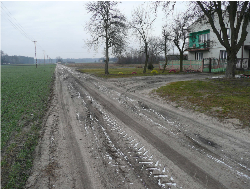
Stan istniejący drogi
