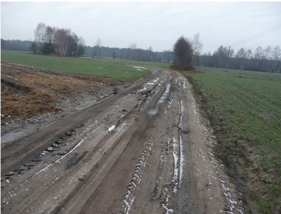
Stan istniejący drogi
