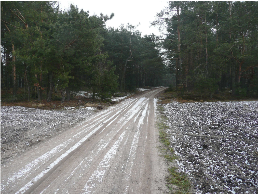
Koniec przebudowywanej drogi.
